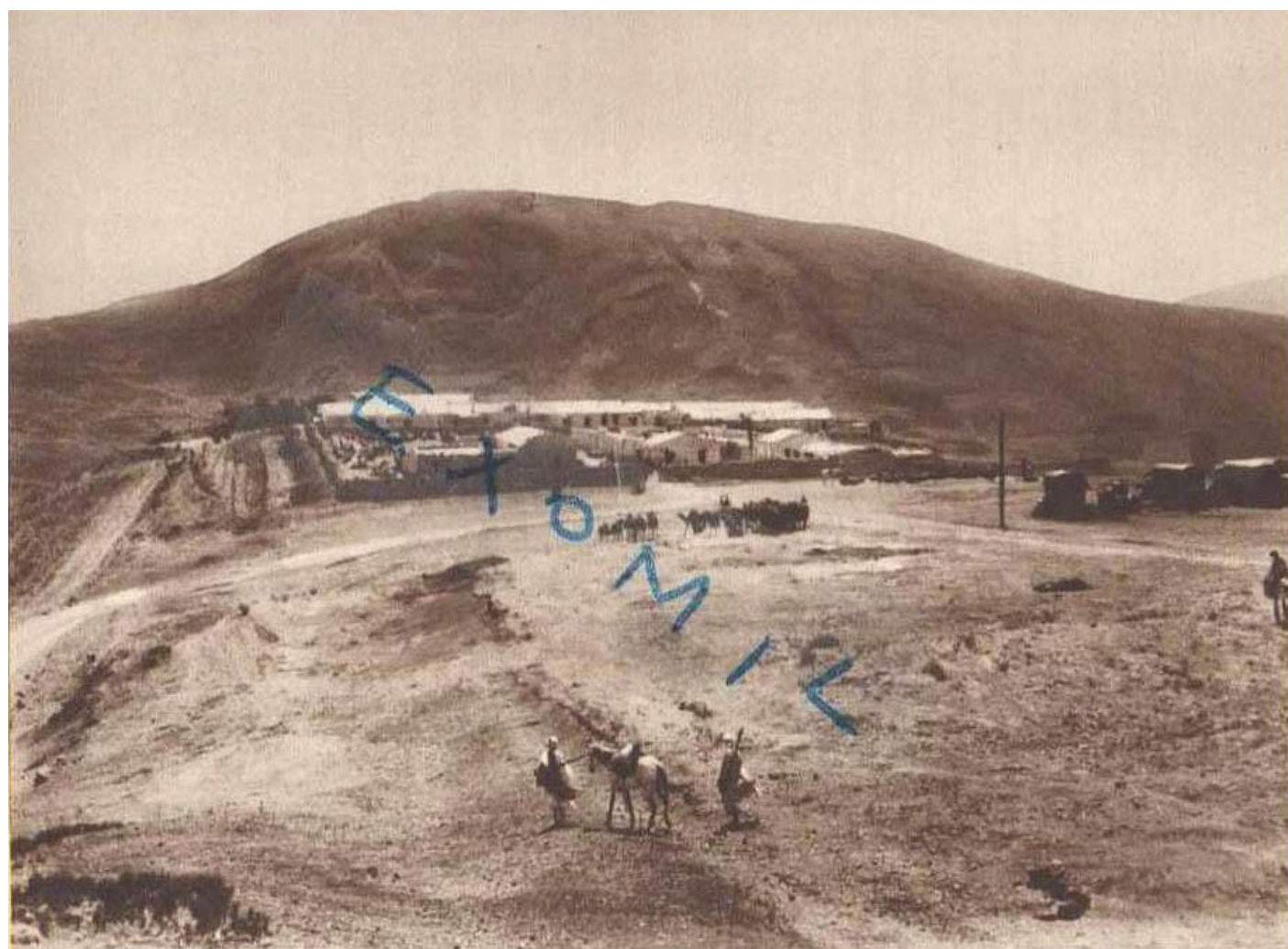
Poste central de la position de Bab-Moroudj.
